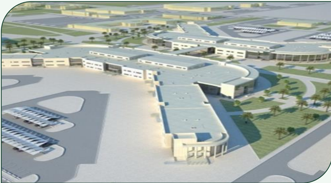
120 مبنى — كلية الملك فيصل الجوية
